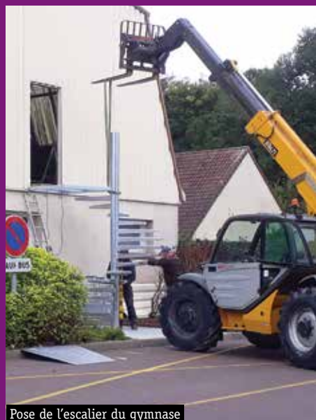
Pose de l'escalier du gymnase
